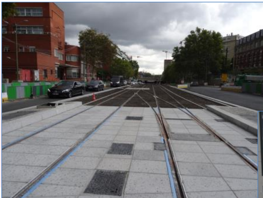
A l'Est du carrefour : la plateforme est construite et le rail est posé (il ne manque plus que le gazon)
