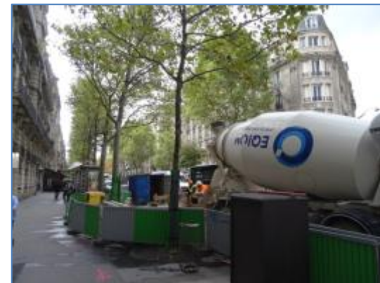
Boulevard Malesherbes travaux d'assainissement
