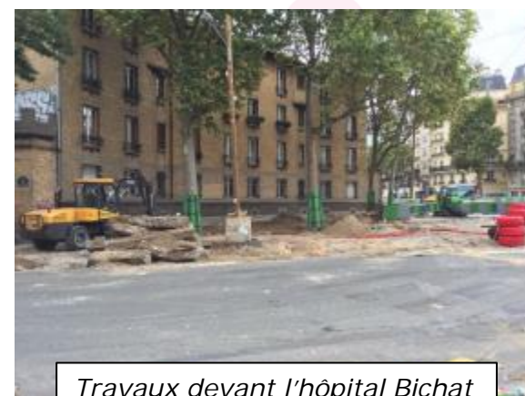
Travaux devant l'hôpital Bichat à la porte de Saint Ouen
