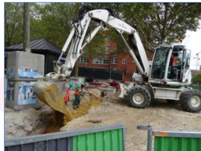
Angle Bd Berthier – Avenue de la Porte d'Asnières : travaux de raccordements réseaux
