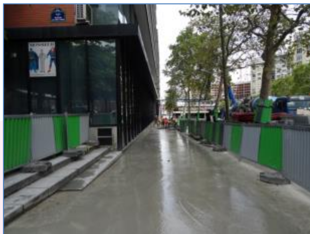
Coulage du béton sur le trottoir entre les rues A. Roussel et M. Long
