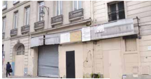
Un immeuble préempté par la Ville de Paris, rue Réaumur.
