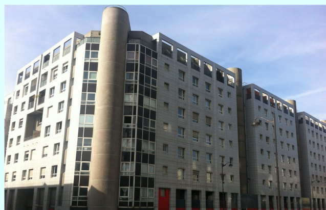
Une dégradation hélas très prévisible. (DR)
