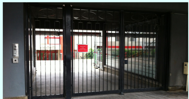
La grille du 9 Boulainvilliers, souvent forcée. (DR)
