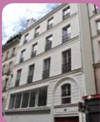
14 rue de Paradis Bailleur : Paris Habitat. 25 logements. Réhabilitation.
