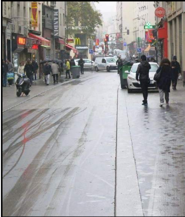
Exemple de rehaussement de chaussée ( rue du faubourg du Temple )
