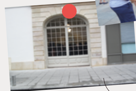
Réhabilitation d'un hôtel particulier rue Réaumur, transformé en immeuble de logements sociaux
