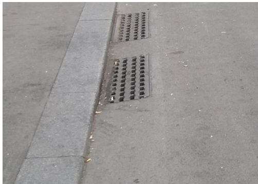
Des contre-allées rechargées en asphalte gris
