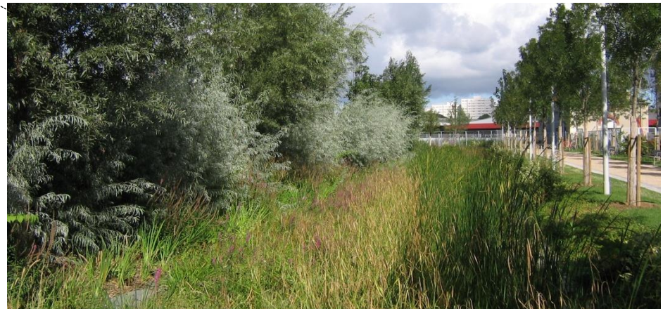
Fossé humide, récupération et infiltration des eaux de ruissellement
