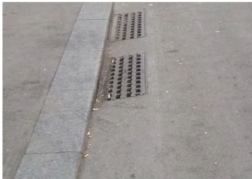
Des contre-allées rechargées en asphalte gris
