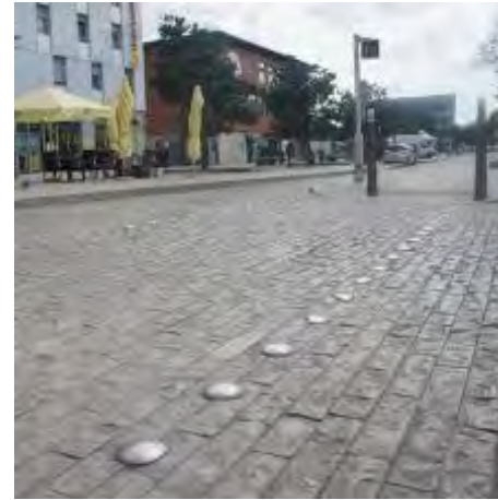
Des clous de voirie pour matérialiser la piste cyclable sur le parvis Sud
