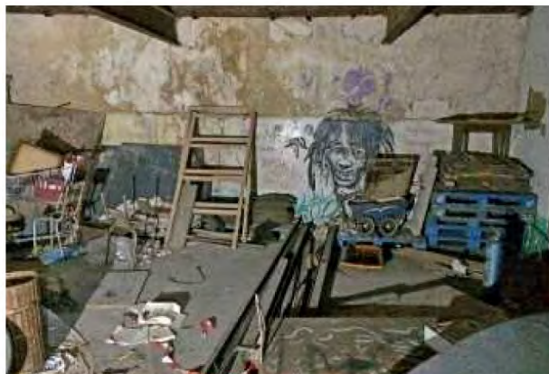
1. Mur gouttereau Ouest
