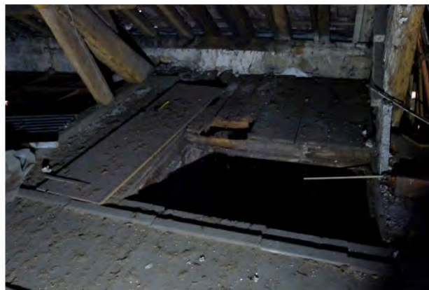
3. Plancher entre la ferm 3 et 4 vers gouttereau Est
