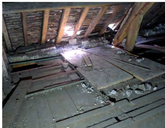
2. Plancher entre la ferm 3 et 4 vers gouttereau Est
