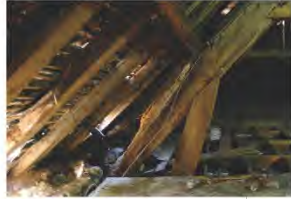
About d'antrait et pied d'arbalétrier ruinés par les venues d'eau : Ferme soutenue par étaieage d'urgence
