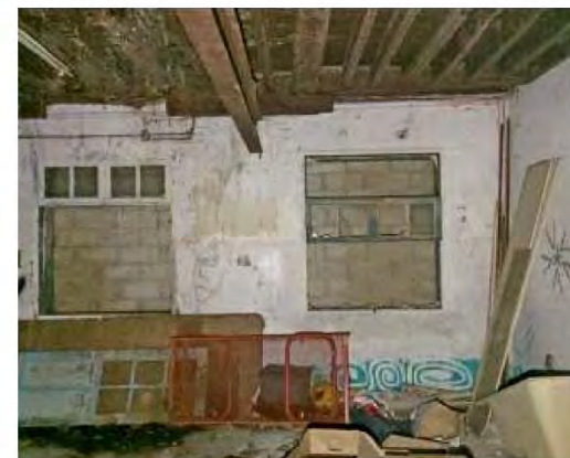
5. Cellier_Mur gouttereau Est
