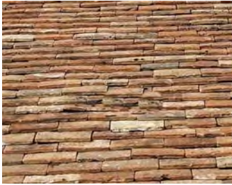
Restauration de la toiture en tuile plates traditionnelles
