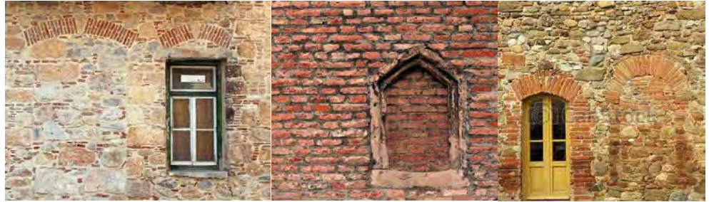
Traitement des baies en remplissage de matériaux du site
