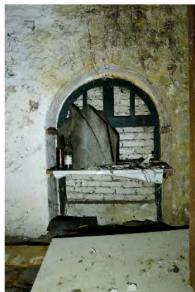
4. Mur gouttereau Est_Baie murée
