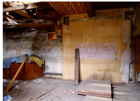
6. Mur gouttereau Ouest
