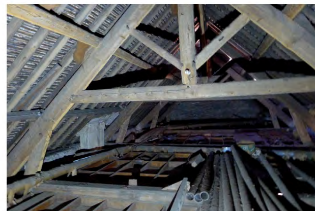
1. Combles Grange vers pignon Sud
