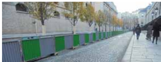
La végétalisation de la rue de Sully se construit jour après jour.
