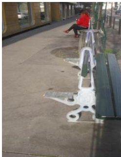
Banc défectueux rue Baudin
