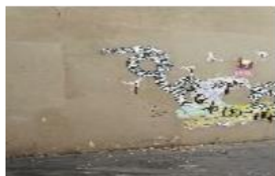
Allée des primevères présence de graffitis
