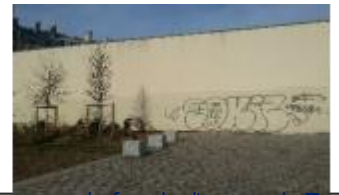
Square Truillot présence sur la façade d'un mur de tags
