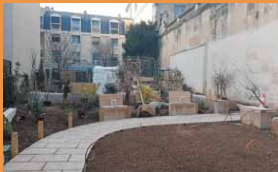
▲ Le jardin en travaux.
