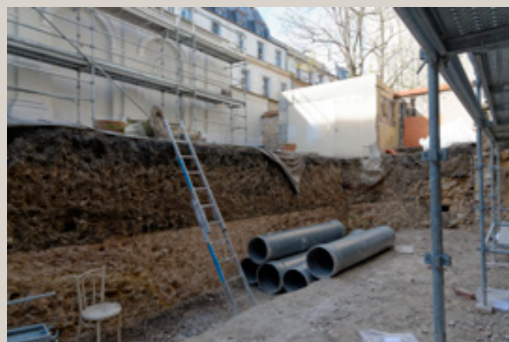
Vue actuelle du jardin décaissé d'un niveau.
