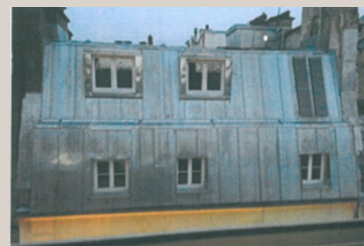
Vue actuelle de la couverture côté rue Grégoire de Tours (© Olivier Lefrançois architecte).
