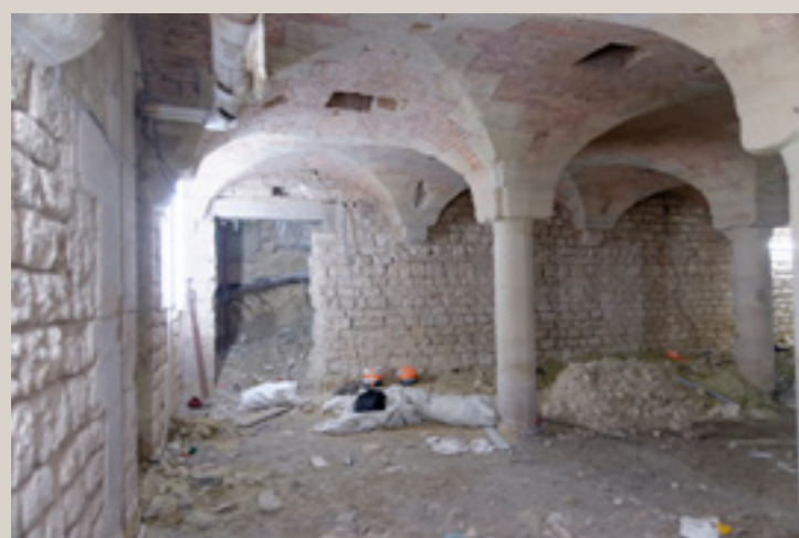
Vue actuelle du sous-sol.
