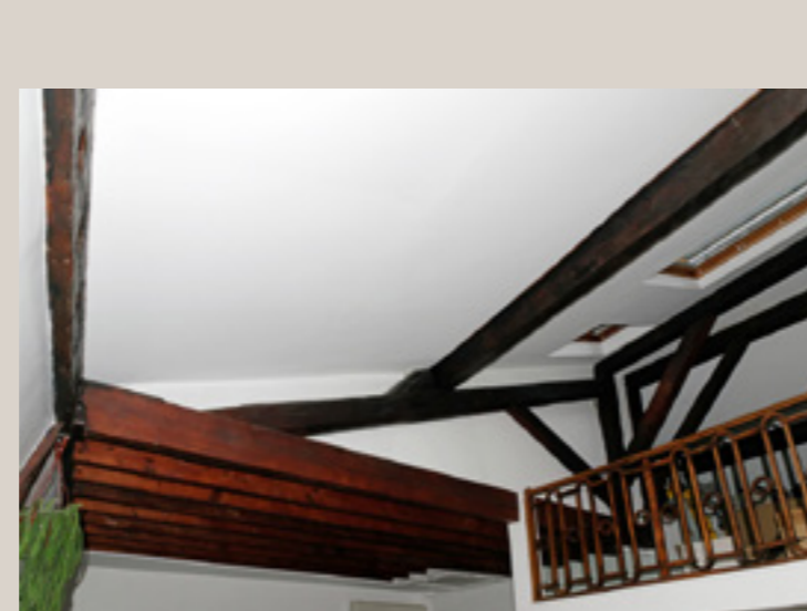
Vues actuelles de la charpente au dernier niveau.
