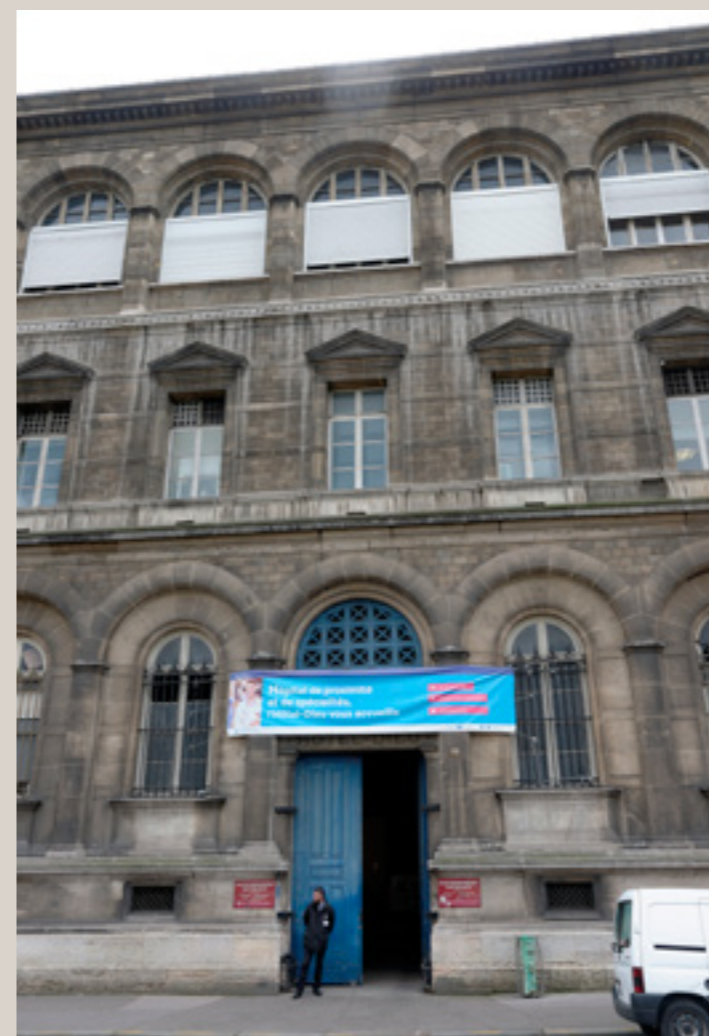
Vue actuelle de l'entrée, quai de Corse (© SCAU architecture).
