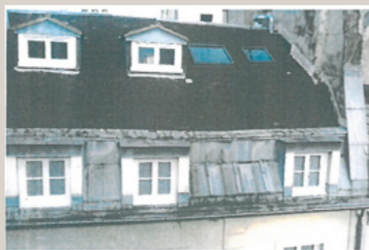
Vue de la couverture, état avant 2015 (© Olivier Lefrançois architecte).
