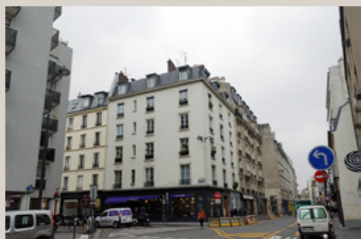
Vue actuelle de l'immeuble depuis l'angle des deux voies.
