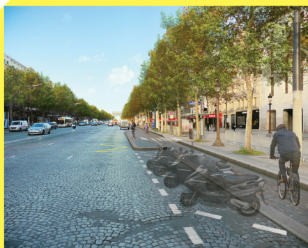
Des passages piétons permettront de rejoindre les quais bus depuis les arrêts.
