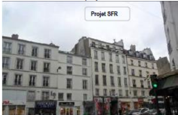
Antennes SFR invisibles depuis l'espace public
