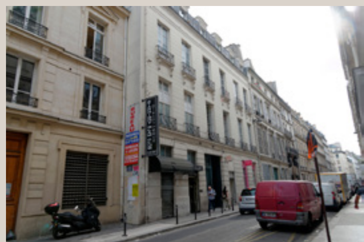
Vue actuelle de la façade sur rue.
