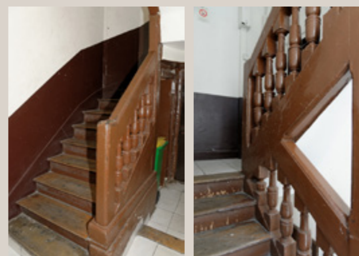
Vues actuelles de l'escalier d'origine.
