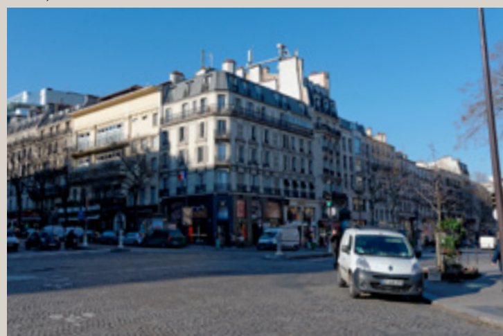
Vue actuelle de l'immeuble depuis l'angle des deux avenues.
