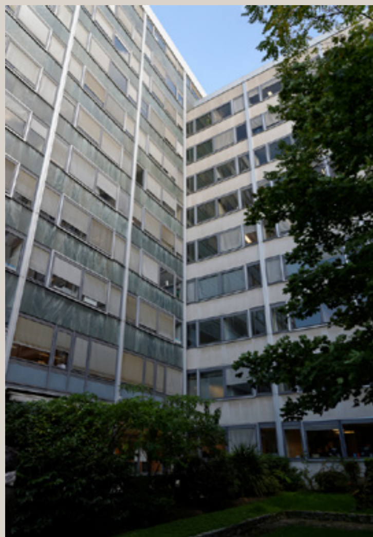
Vue de l'articulation entre le bâtiment principal et une aile de bureaux.
