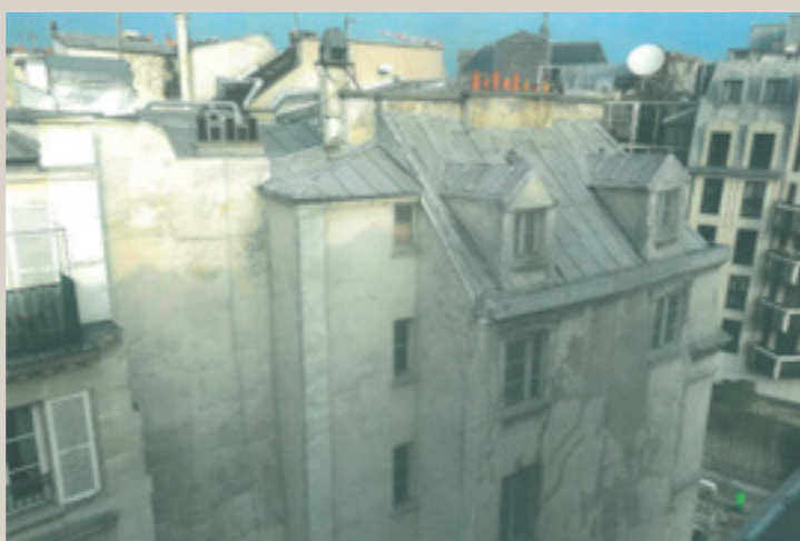
Vue de la toiture (© SAS FH Architecture).
