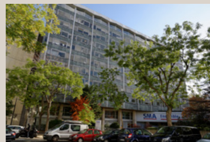
Vue actuelle du bâtiment depuis l'avenue Émile-Zola.
