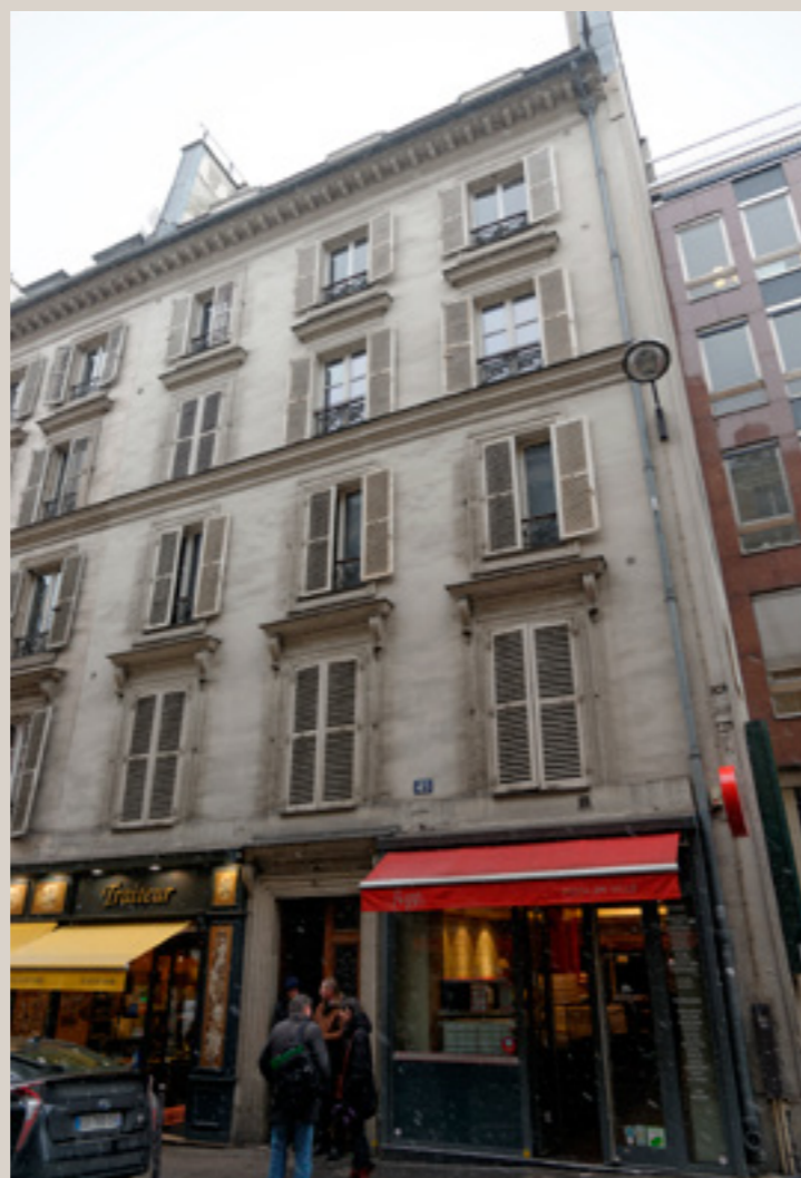
Vue actuelle de la façade sur rue.
