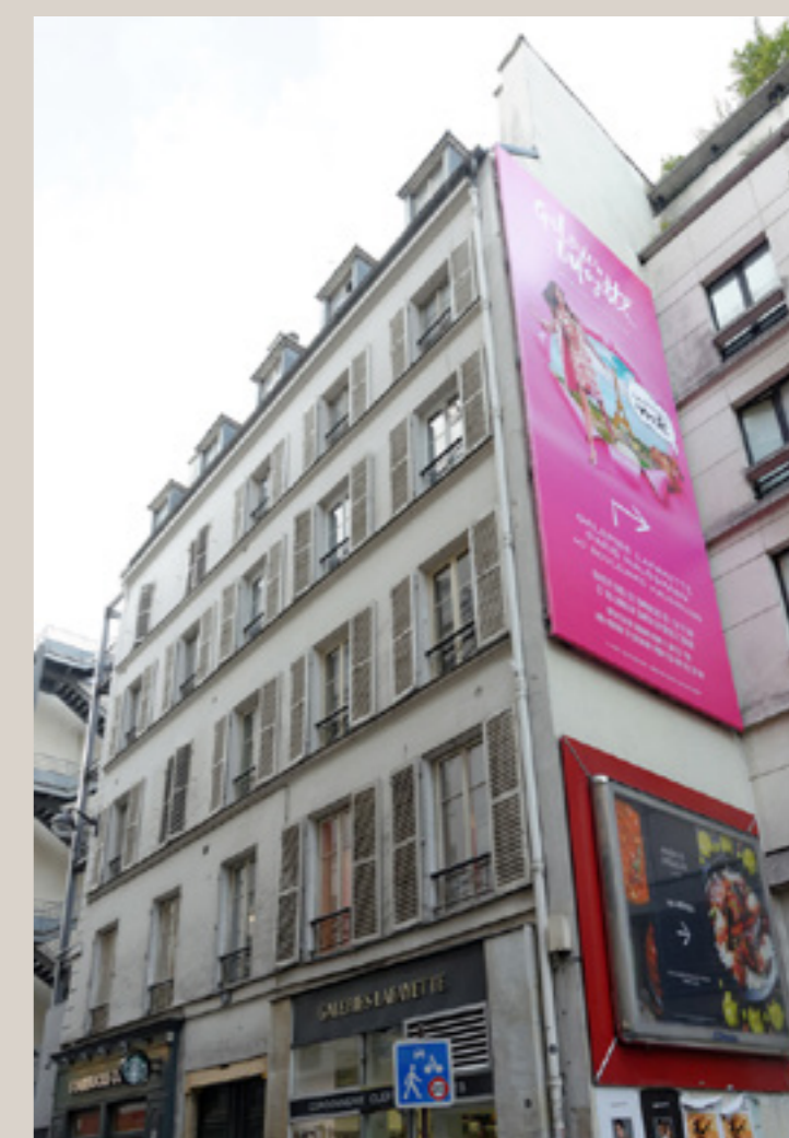
Vue actuelle de la façade sur rue.
