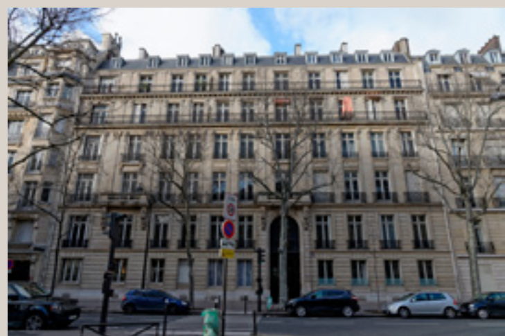
Vue actuelle de la façade sur l'avenue.
