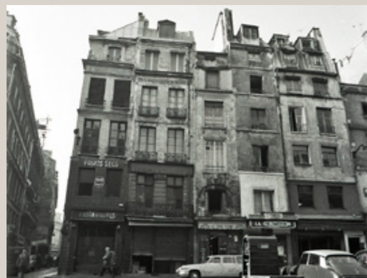
Vue de la façade sur la rue Saint-Honoré en 1975 (Casier archéologique).
