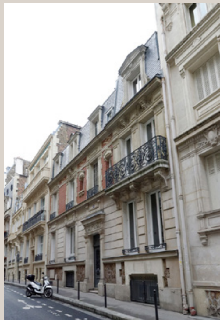
Vue actuelle de la façade sur rue.
