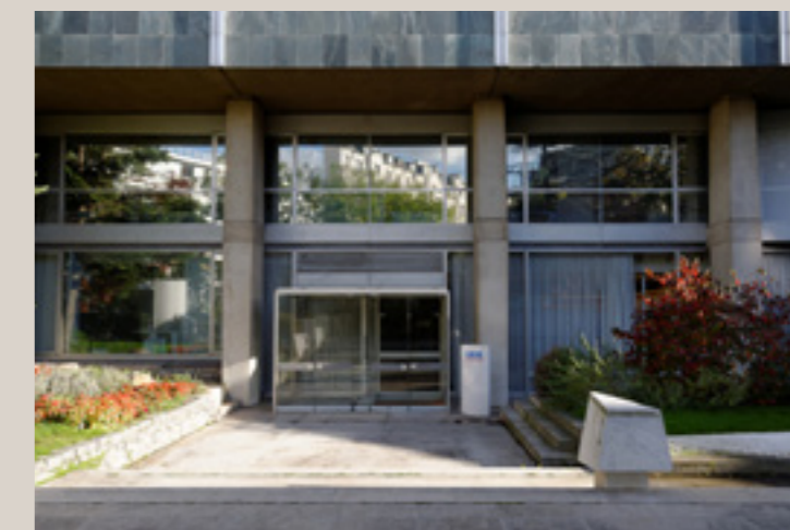
Vue actuelle de l'entrée du grand hall montrant la structure basse de l'immeuble, côté avenue Émile-Zola.
