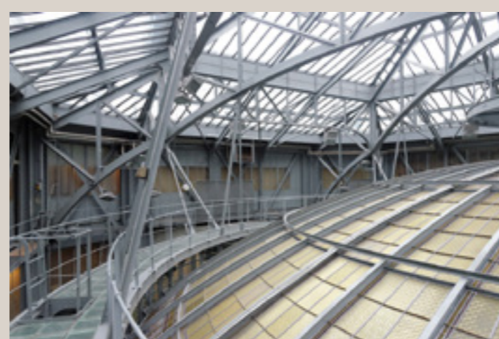
Vue actuelle de la charpente métallique protégeant la coupole.
