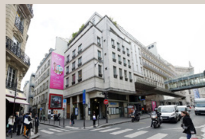
Vue actuelle depuis l'angle de la rue de Provence et de la rue de Mogador.
