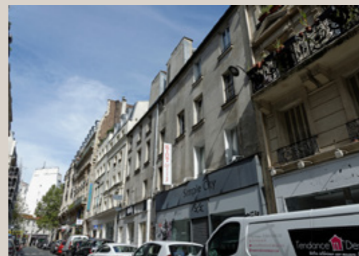
Vue actuelle de la façade sur rue.
