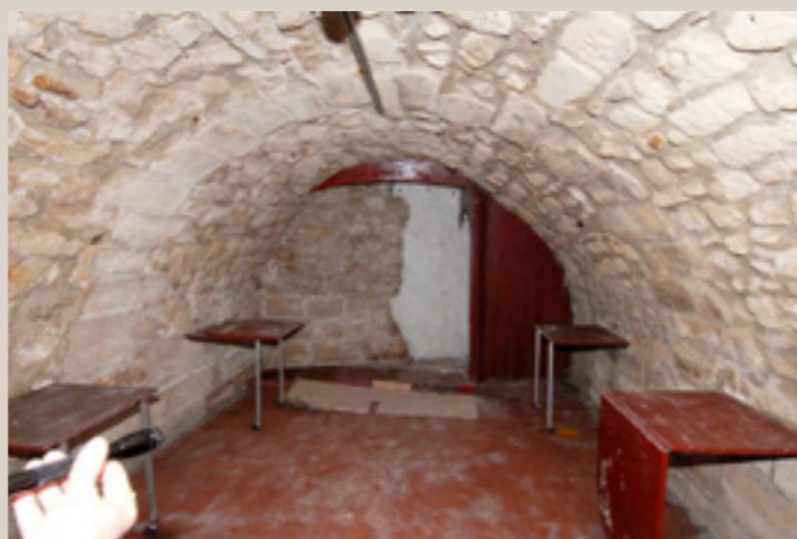
Vue des voûtes du sous-sol.
