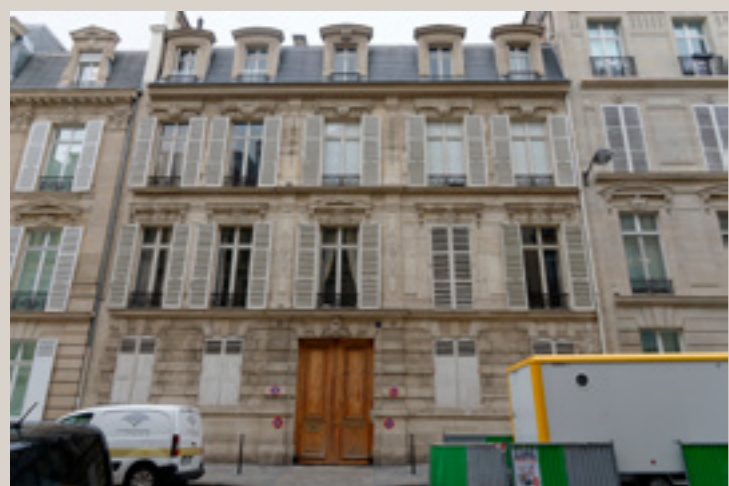
Vue actuelle de la façade sur rue.
