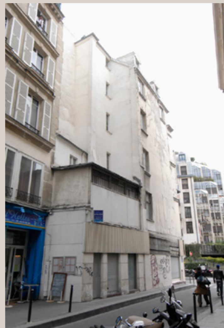
Vue du bâtiment depuis la rue des Bourdonnais en 2009.
