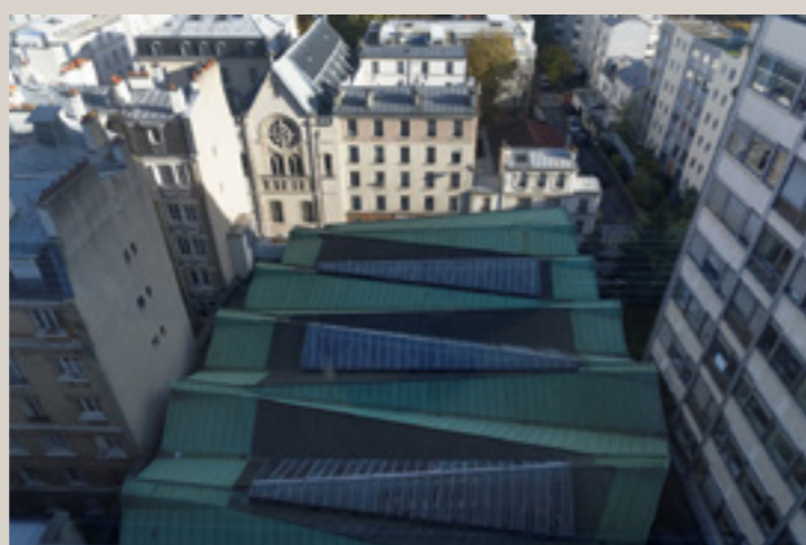
Vue actuelle de la toiture du bâtiment de l'auditorium.
