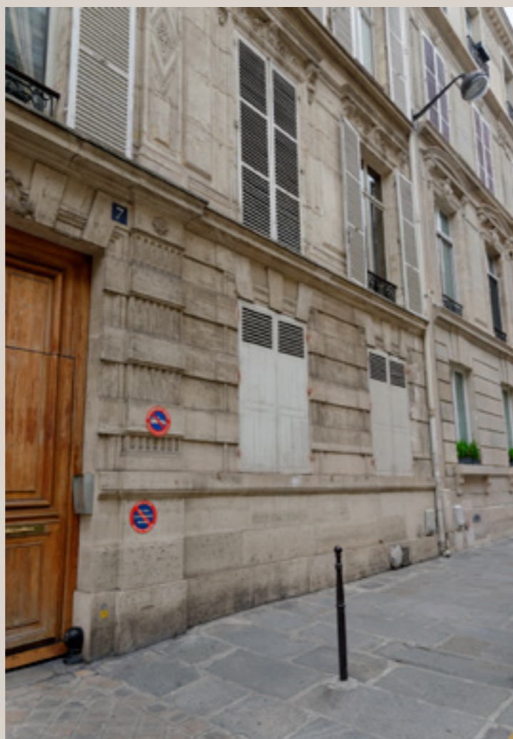
Détail de la façade sur rue, état existant.
