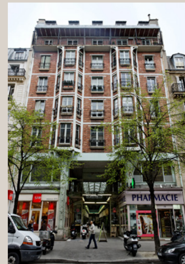
Vue actuelle de la façade sur l'avenue.
