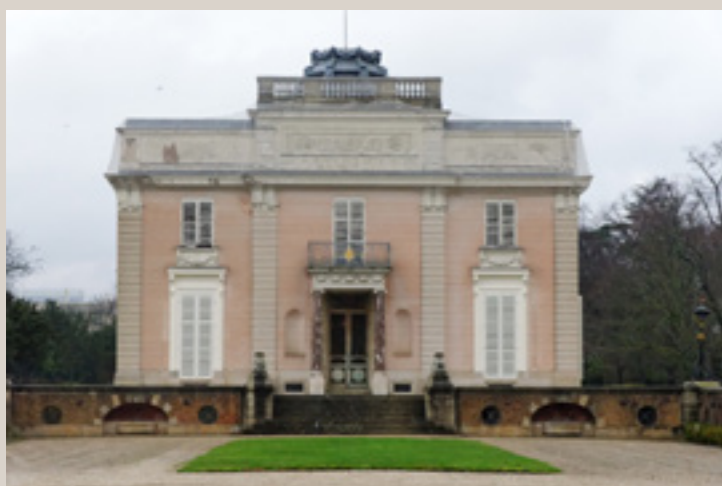
Vue actuelle de la façade du pavillon donnant sur la cour d'honneur. Les parties hautes sont entourées d'un filet de protection.
