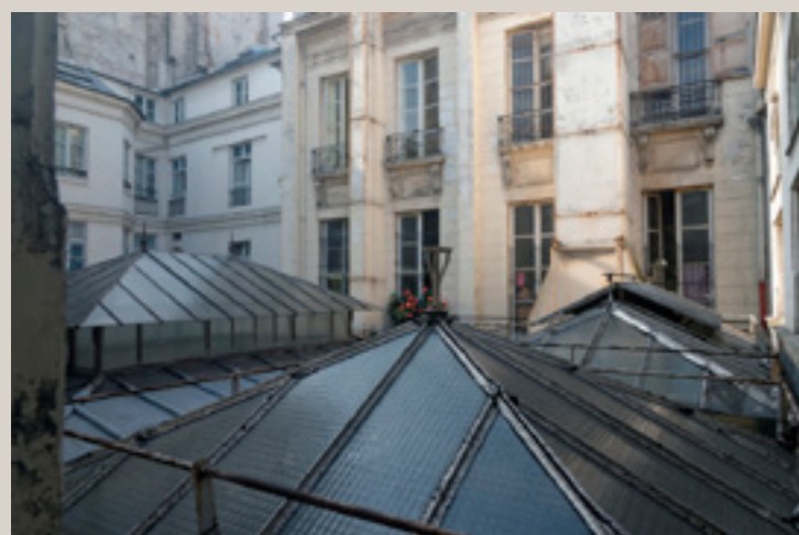
Vue actuelle des verrières métalliques couvrant l'ancienne cour.
