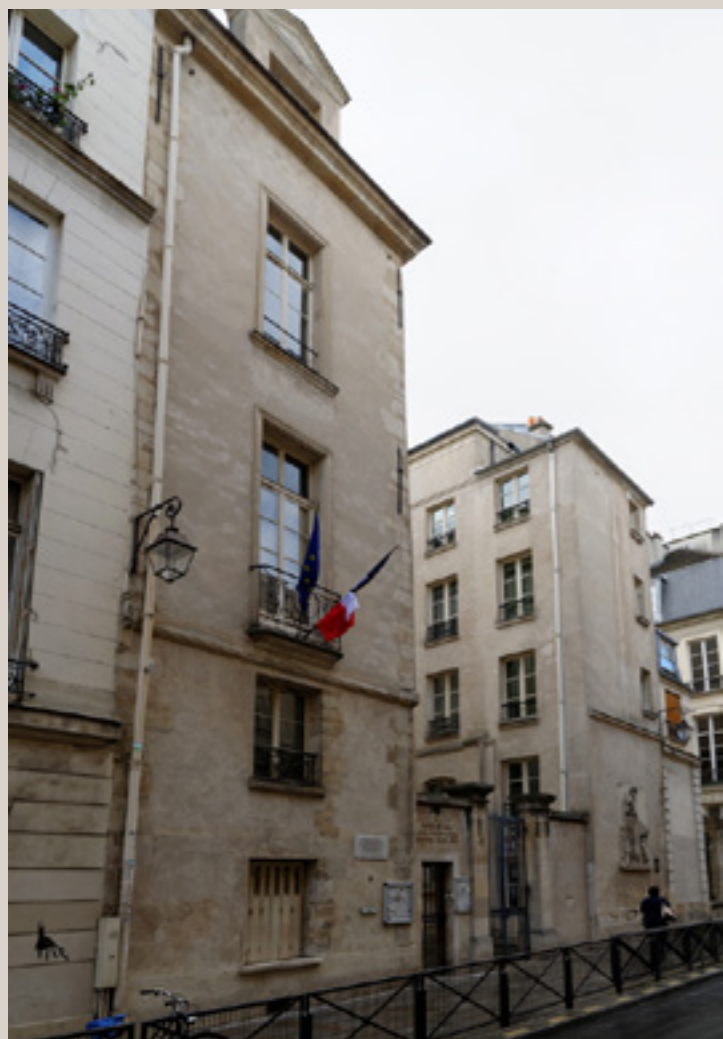
Vue de l'hôtel depuis la rue de Sévigné.
