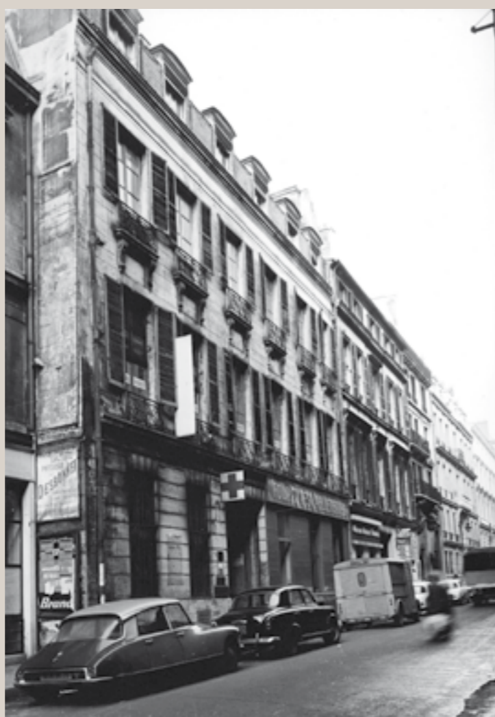
Vue de la façade sur rue en 1966 (Casier archéologique).
