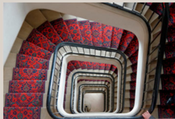
Vue actuelle de l'escalier principal.
