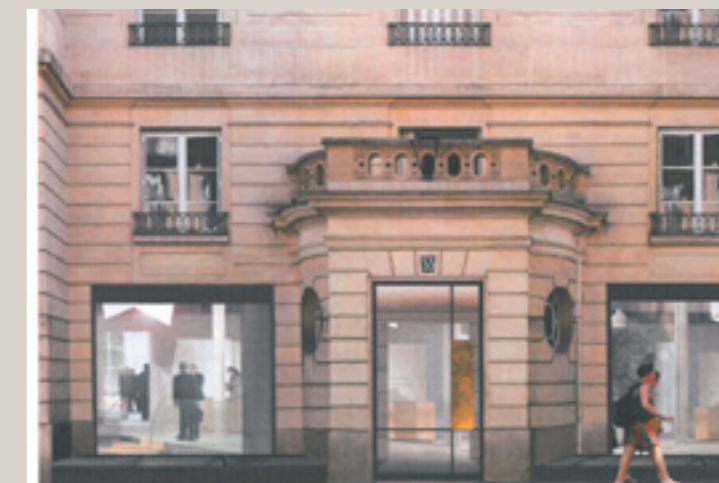
Vue d'insertion du projet d'agrandissement des baies de part et d'autre du porche (© Morris & Renaud architectes).
