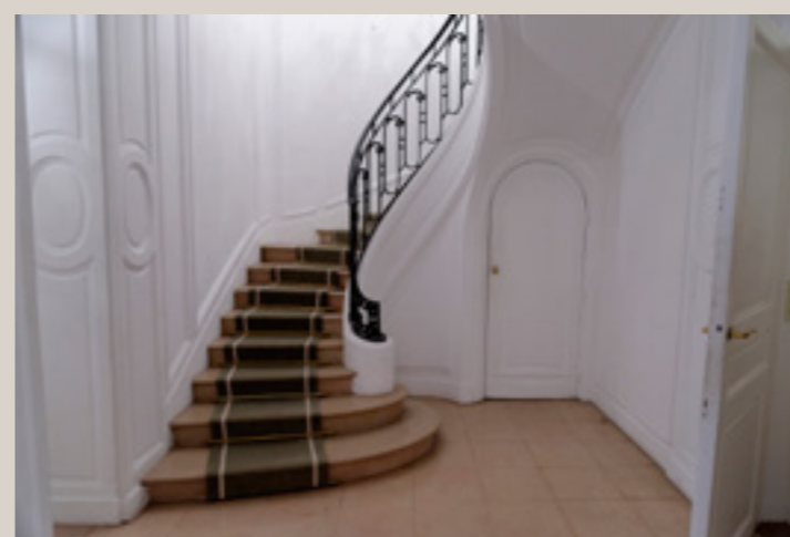
Vue actuelle de l'escalier reliant le rez-de-chaussée à l'entresol.
