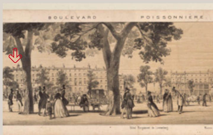
A. Provost, Panorama intérieur de Paris : Boulevard Poissonnière (détail), 1842 (© BnF). L'actuel n° 22 est figuré à l'extrémité gauche de l'estampe. La percée au centre correspond à l'hôtel Rougemont.
