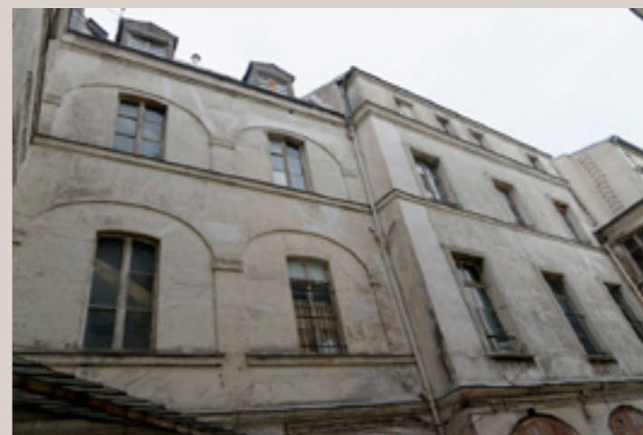
Façade sur cour de l'aile gauche. On y remarque les grandes arcades surbaissées datant probablement du milieu du XVII e siècle.
