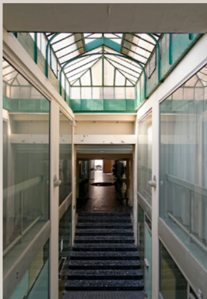
Vue de l'état actuel sous les verrières (au fond, le portail d'entrée).
