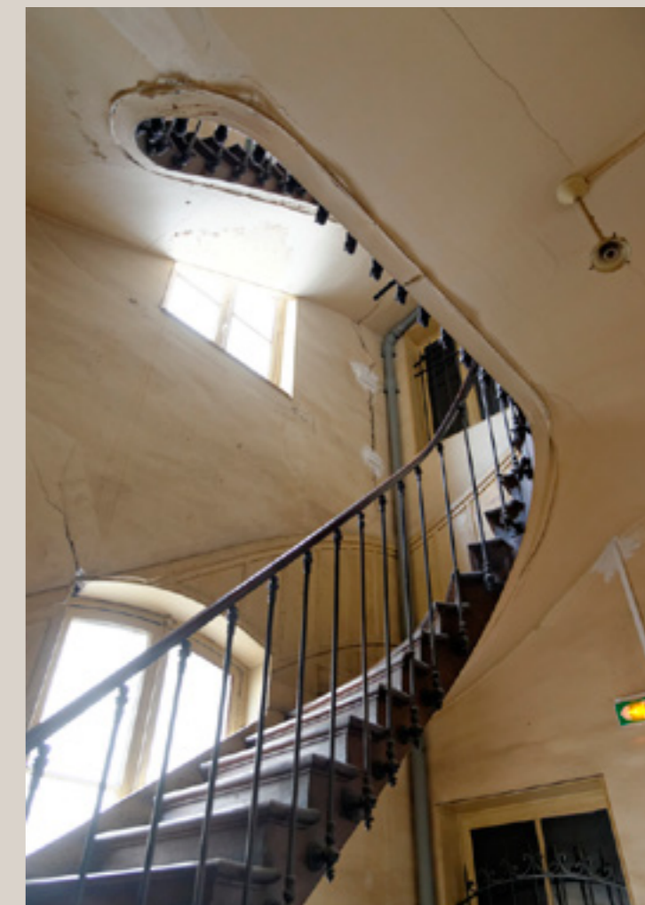
Escalier à barreaux de fonte desservant les étages de l'aile gauche (XIX e siècle), remplaçant l'ancien escalier de pierre au même endroit.
