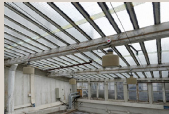
Vue actuelle de la verrière extérieure.
