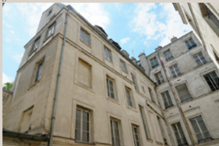
Façade sur cour de l'aile droite.
