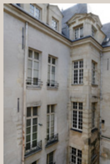
Tourelle abritant l'escalier principal.
