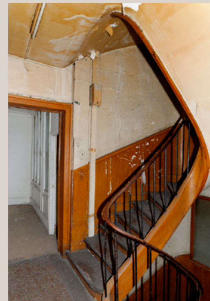
Vue actuelle de l'escalier principal.
