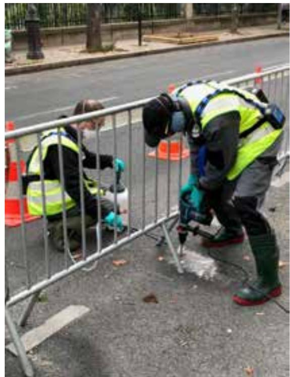
*Chantier de perçage d'enrobés de chaussée amiantés*
