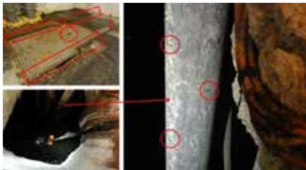
*Les moustiques proviennent d'une trappe au sol du local technique, lequel abrite une pompe de relevage. Les moustiques s'échappent de cette trappe non scellée et la présence de l'eau convient parfaitement à leur installation dans cet environnement.*
