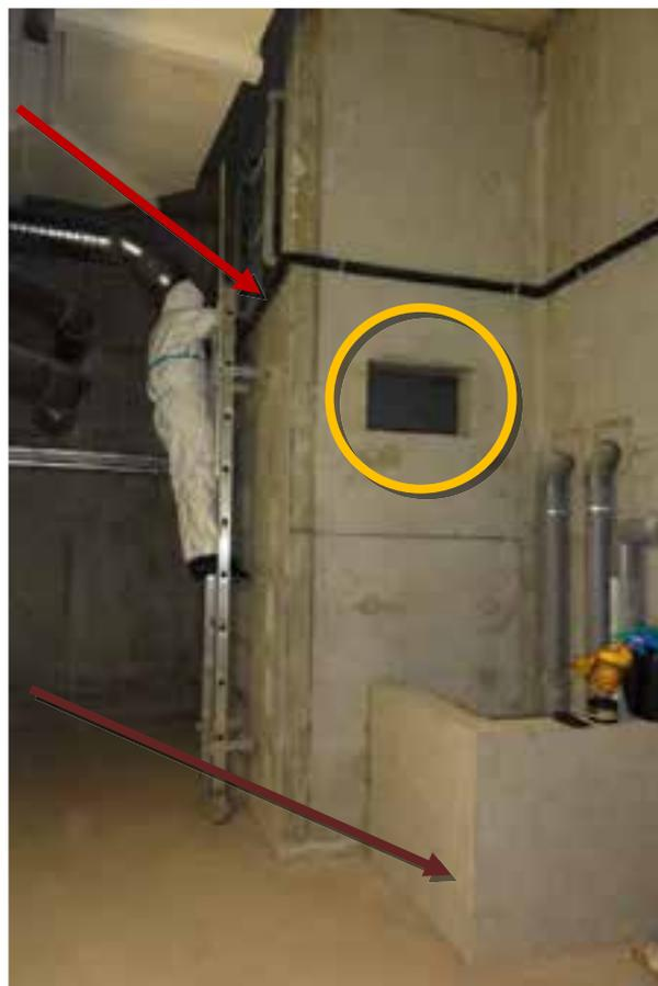
*Traitement larvicide dans une cuve de récupération d'eau pluviale Sur la plateforme (flèche rouge), deux trappes nous indiquent la présence de deux cuves séparées (confirmation effectuée par observation directe). Il est à noter que ces cuves possèdent trois « lucarnes » (cercle jaune) ainsi qu'un siphon de sol dans le bâti juxtaposé à la cuve (flèche marron) d'où nous avons observé des moustiques adultes qui s'en échappaient par dizaines.*
