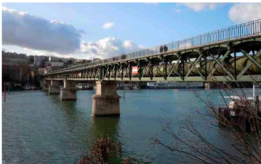
Passerelle de l'Avre en franchissement de la Seine
