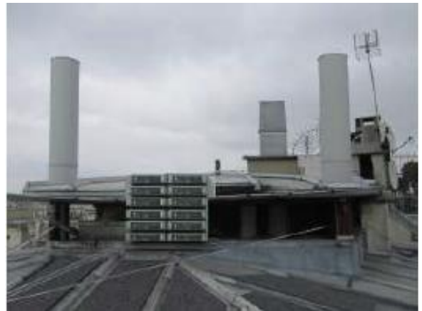
Installation des antennes tube SFR et des modules radio
