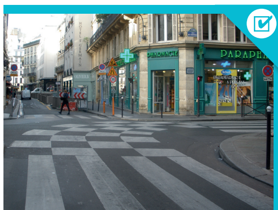
Positionner le totem en amont du chantier si possible entre la première barrière de l'emprise et le carrefour.
