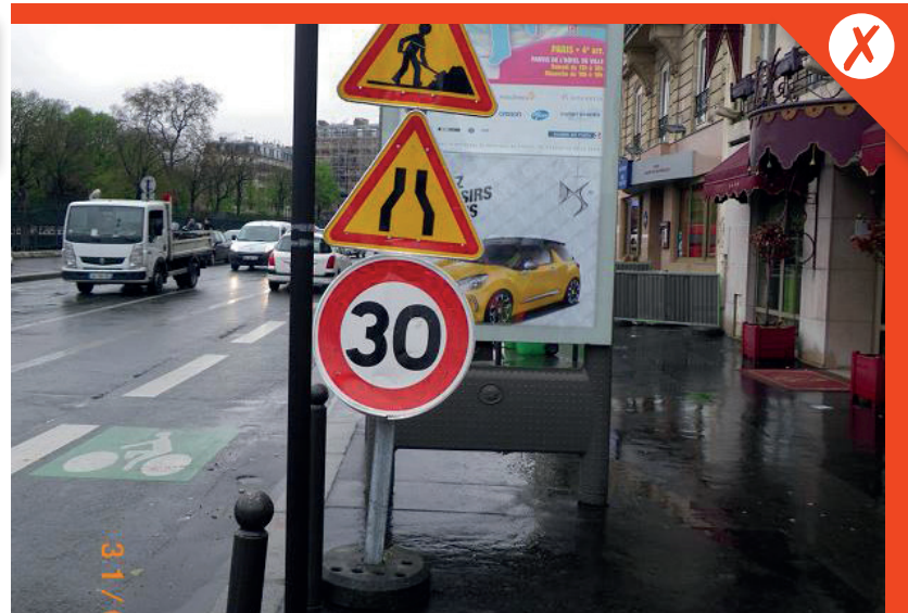
Le support de la signalisation temporaire doit être scellé au sol ou fixé sur un mobilier existant.
