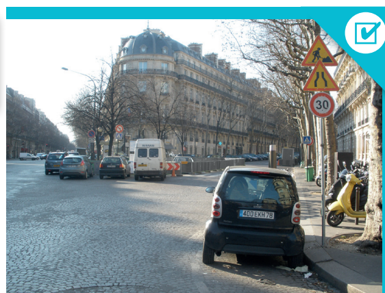
Sceller le totem à droite de la circulation. Un rappel à gauche peut être nécessaire si chaussée large et à sens unique.
