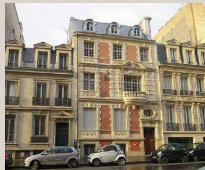
Vue actuelle du bâtiment depuis la rue Jouffroy d'Abbas.
