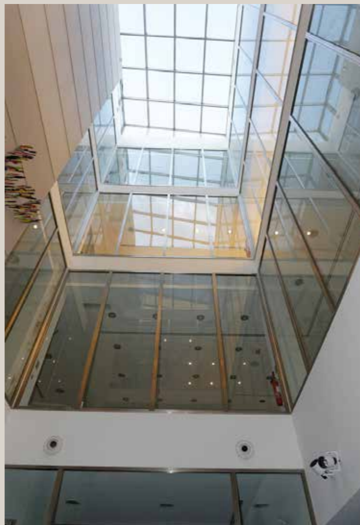
Vue actuelle du patio et de la verrière.
