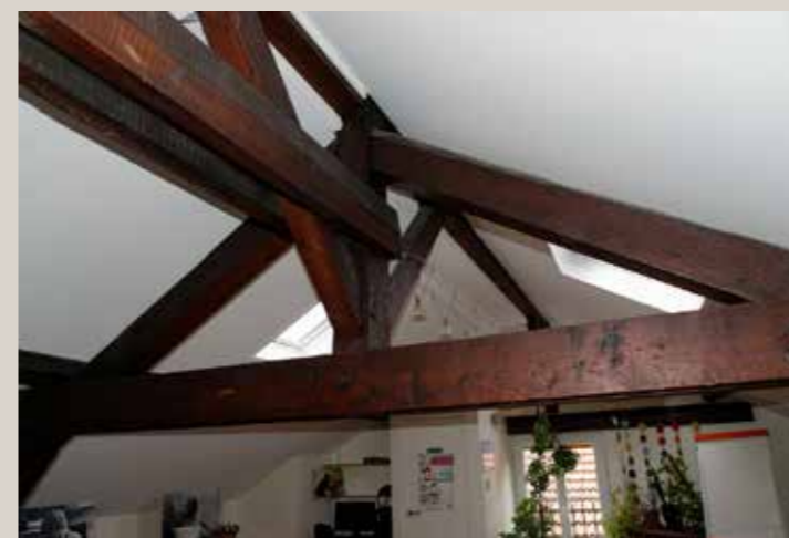
Vue actuelle de la charpente.
