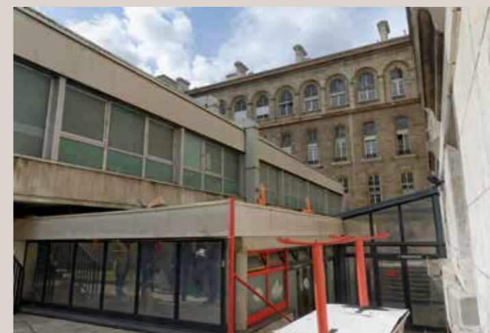
Vue actuelle d'un bloc opératoire dans une cour latérale.
