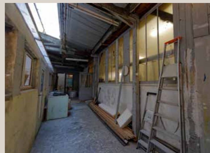
Vue de la cour couverte et de la construction précaire à démolir (à gauche).
