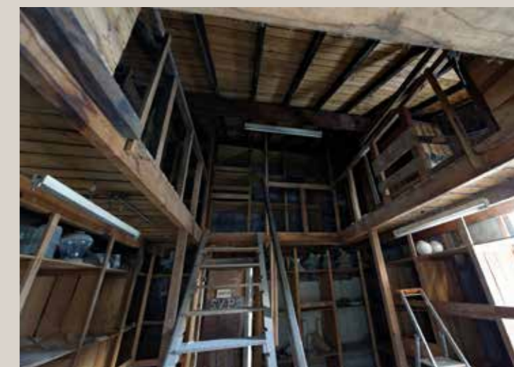
Vue des anciens ateliers dans la partie de l'aile qui serait surélevée.
