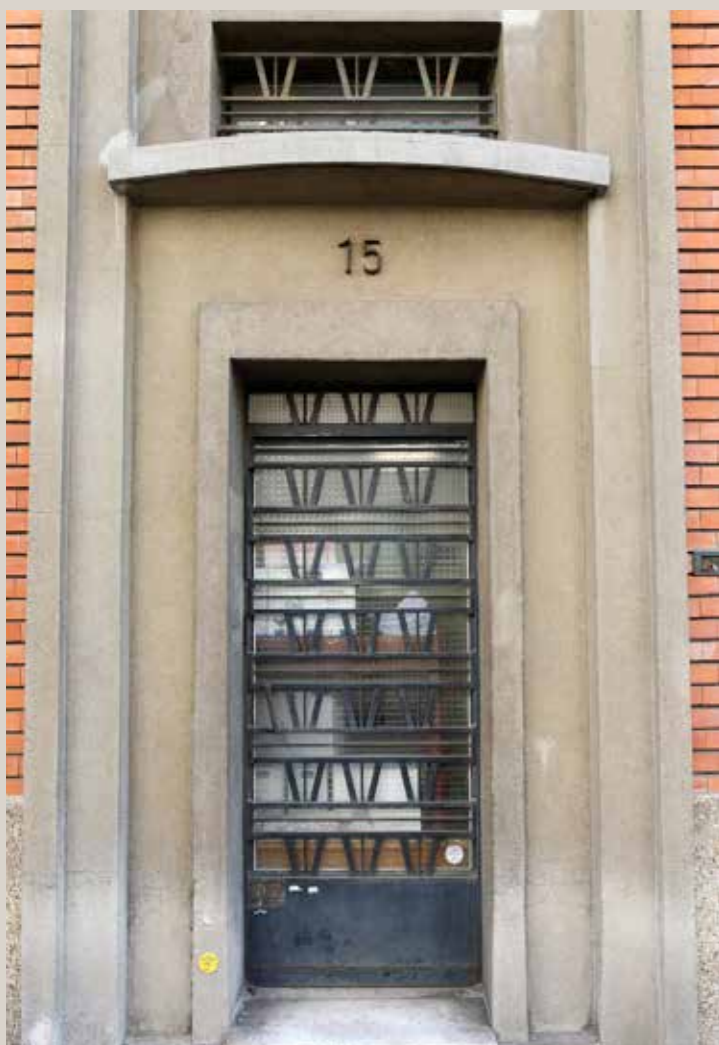
Vue de l'entrée sur la rue de Messidor (corps de bâtiment édifié en 1955).
