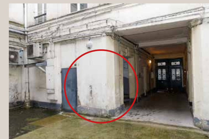
Vue du passage cocher depuis la cour et du futur emplacement du sas d'entrée dans le bâtiment principal
