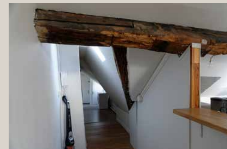
Vue actuelle de la panne et de la jonction entre les charpentes des deux bâtiments.
