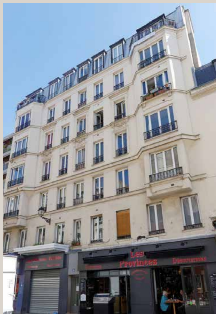
Vue actuelle de la façade de l'immeuble sur la rue d'Aligre (hors projet).
