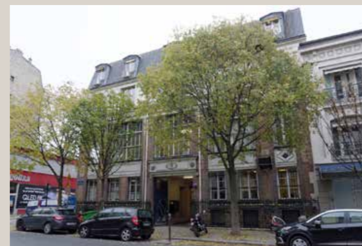
Vue actuelle de la façade sur l'avenue.
