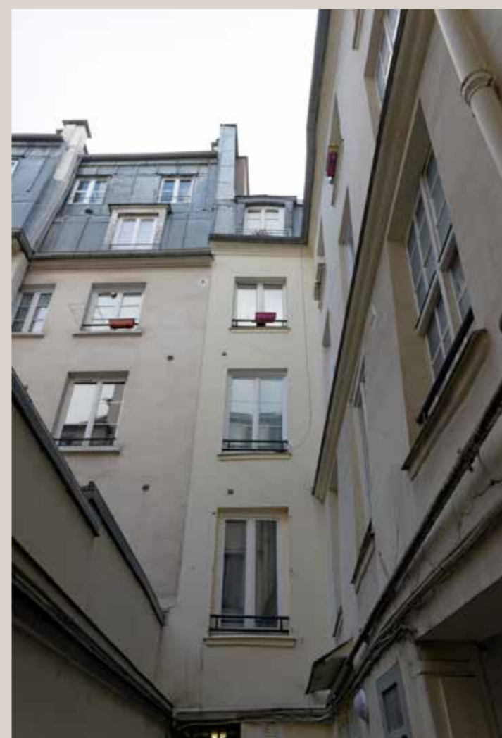
Vue actuelle de la façade sur cour du bâtiment principal et de l'aile en retour.
