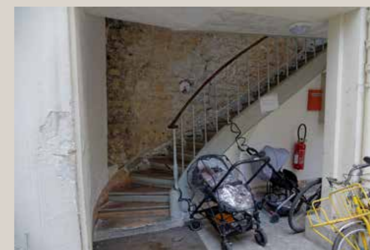
Vue actuelle du départ de l'escalier XVIII e .
