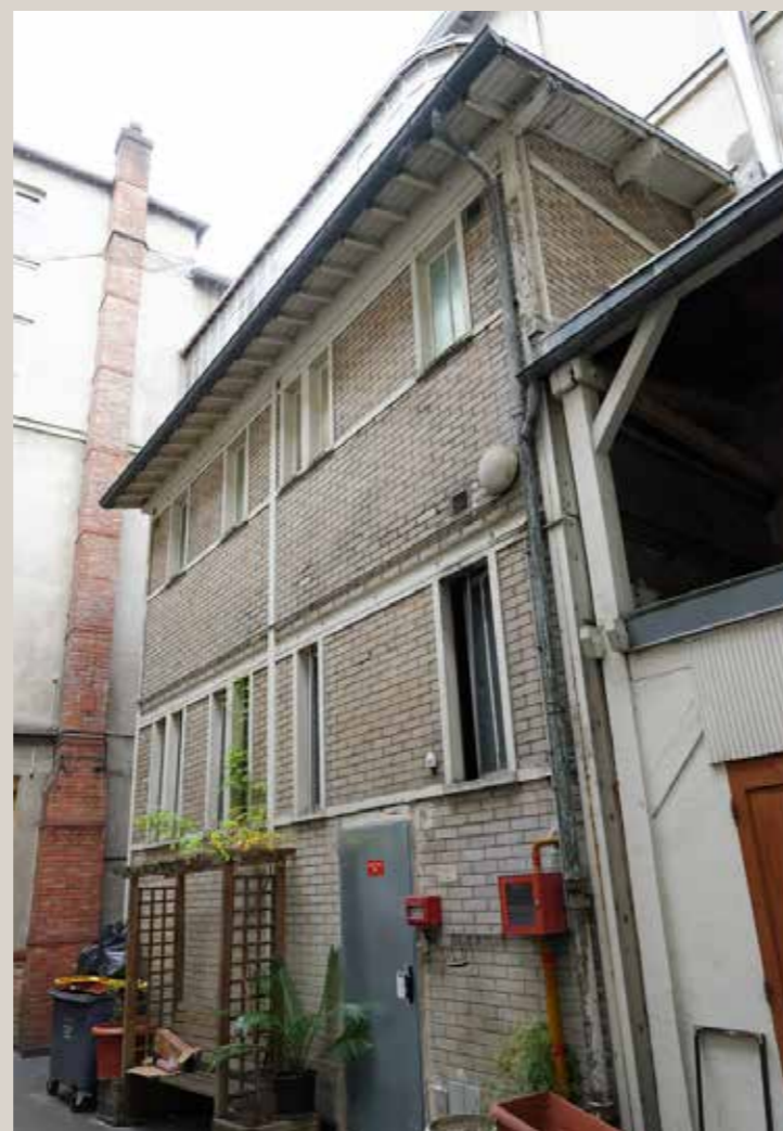
Vue actuelle de l'extension élevée dans la cour en 1920.
