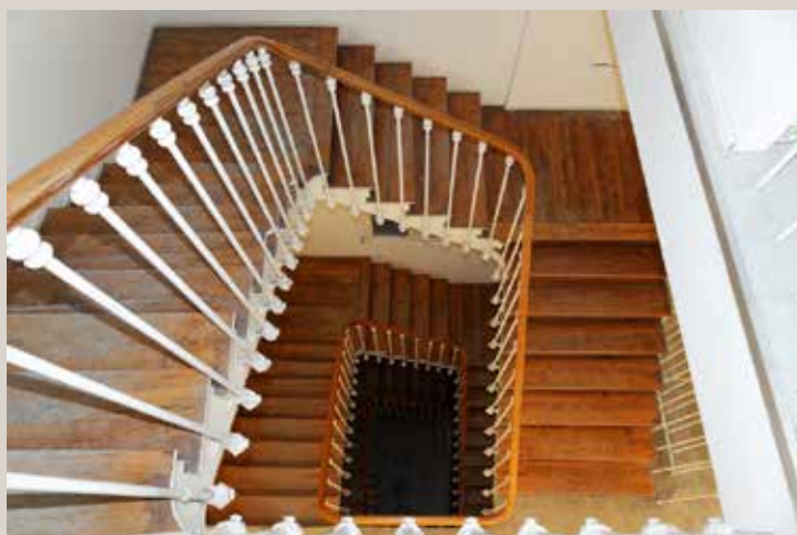
Vue actuelle de l'escalier principal.
