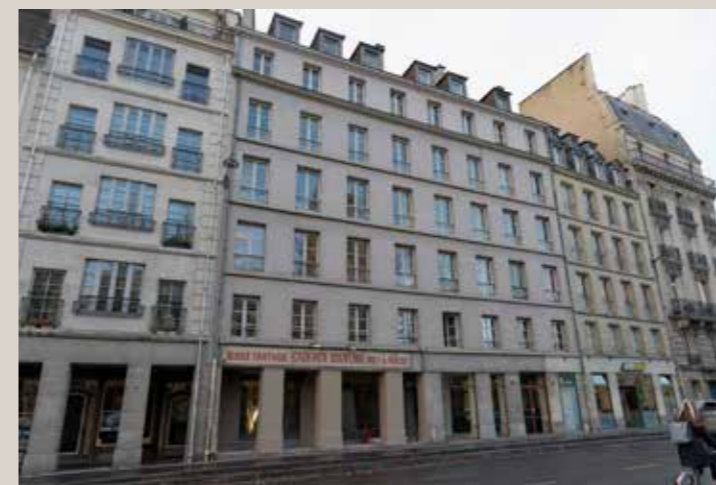
Vue actuelle de la façade sur le quai.
