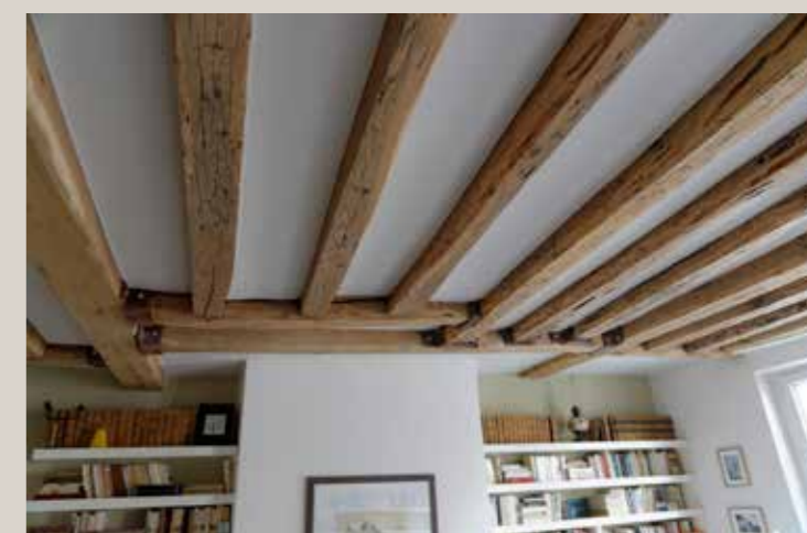
Vue actuelle des éléments de charpente conservés.
