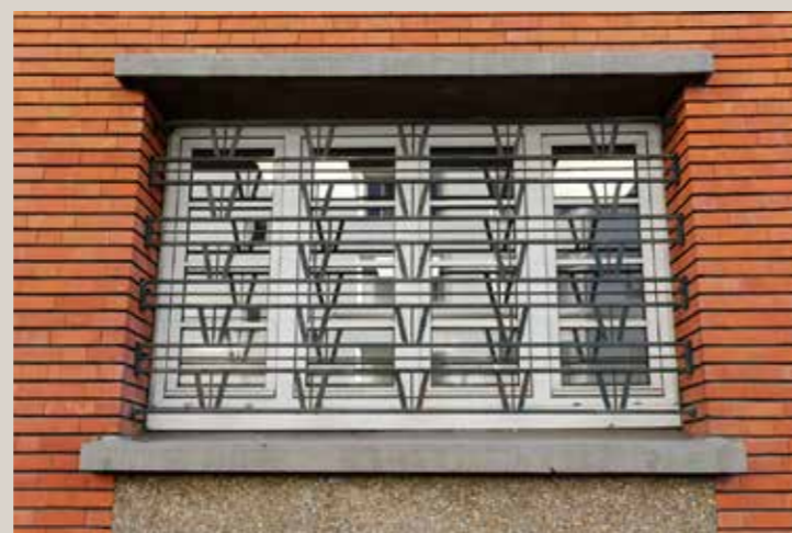
Vue d'une fenêtre du rez-de-chaussée (corps de bâtiment édifié en 1955).
