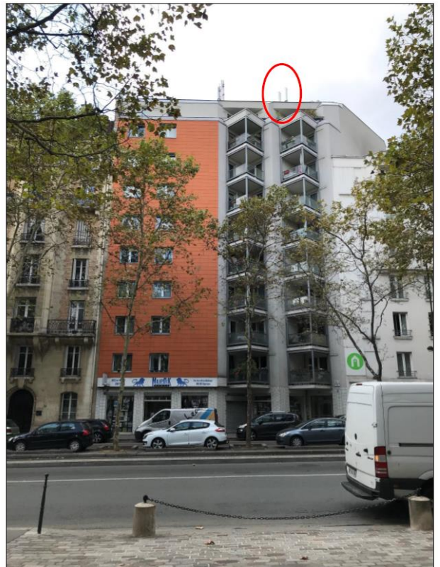
Pas de changement de l'état visuel
