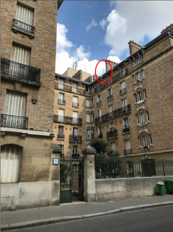
Pas de changement de l'état visuel
