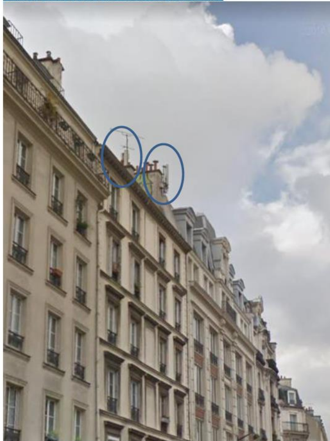
Etat projeté : pas de modification visible
