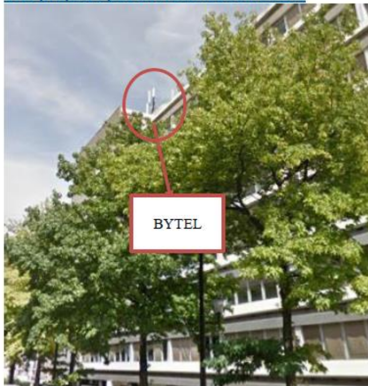
Etat projeté : pas de modification visible
