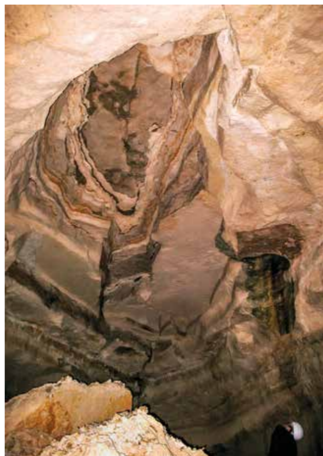
Exemple de fontis dans une ancienne carrière souterraine de gypse
