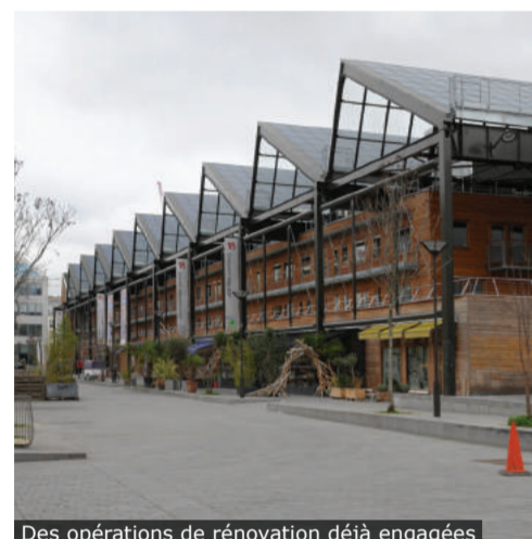
Des opérations de rénovation déjà engagées
