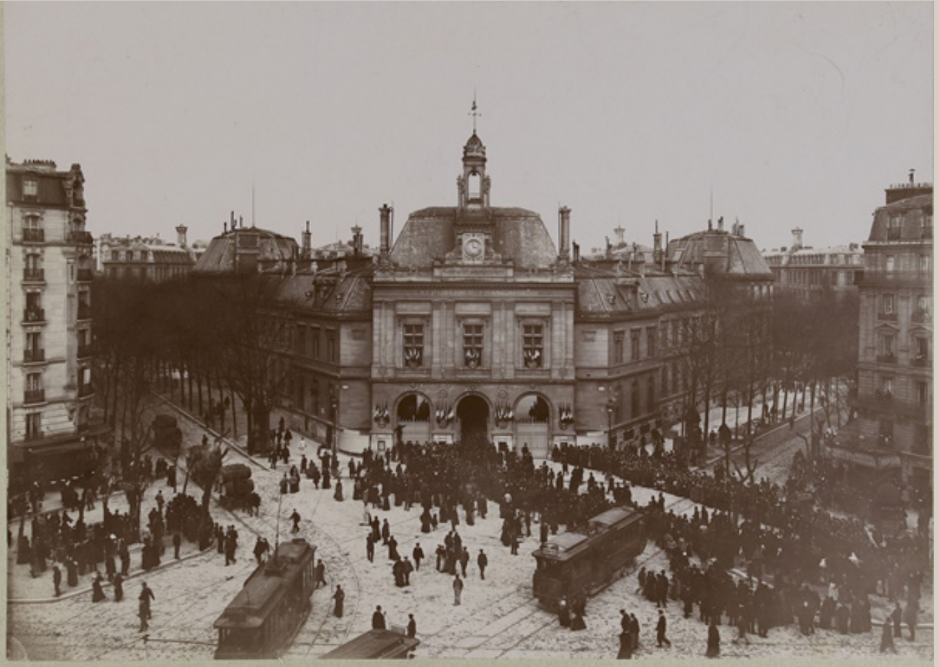
Fig. 15 - Vue de la place au début du XXe siècle, montrant notamment passage des plusieurs lignes de tramway et l'apparition des entrées du métropolitain sur les îlot périphériques.
