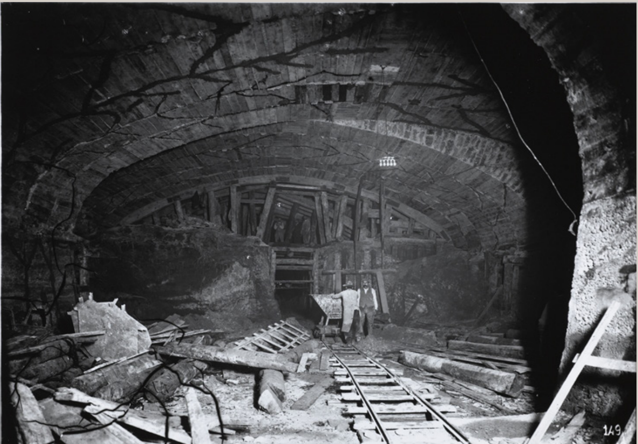
Fig. 16 - Le chantier de construction de la ligne 3 du métropolitain sous la place Gambetta en octobre 1904.
