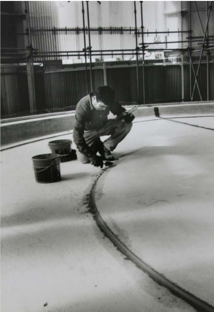
Fig. 41 - Chantier de la fontaine, 1991.
