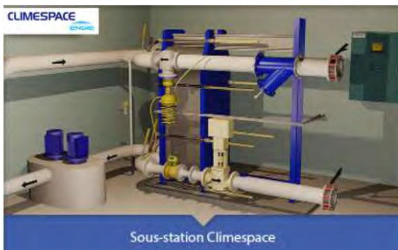
Le froid est livré aux abonnés du réseau (commerces, bureaux, musées, bâtiments publics, bâtiments industriels, logements...) à partir d'un branchement effectué sur le réseau principal de distribution. Le froid contenu dans l'eau glacée de la canalisation aller du réseau primaire est transféré vers le réseau secondaire via un échangeur installé dans le poste de livraison. Le débit de livraison est régulé en permanence dans
